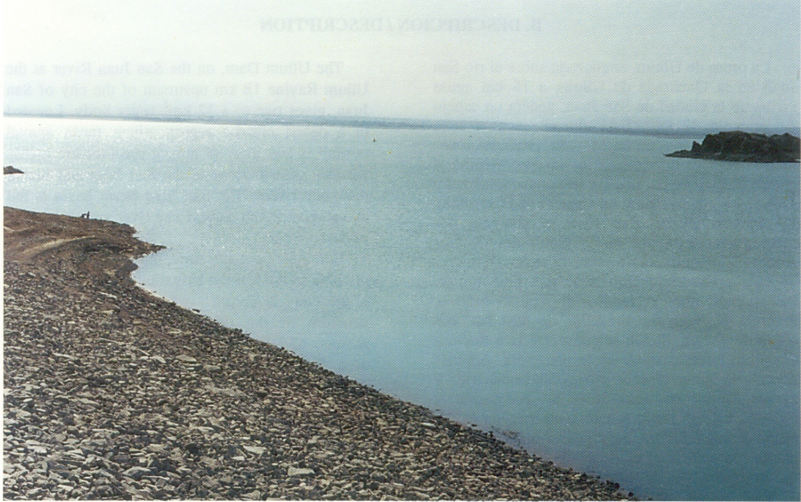
Foto: Departamento de Hidráulica de la Prov. de San Juan
